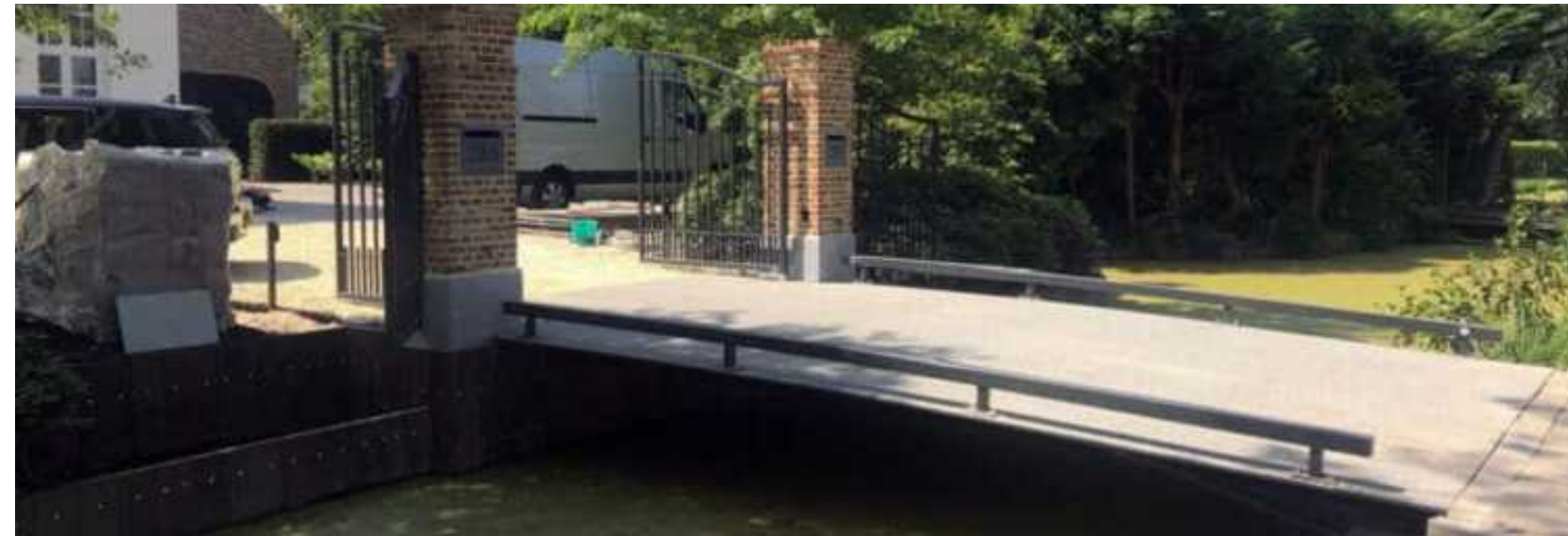
2: BETONNEN BRUG MET LAGE RAILING
